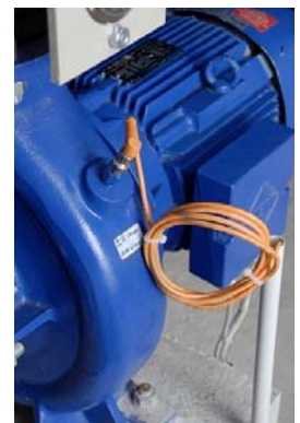
Bild 15: Filtratpumpen mit effector octavis
