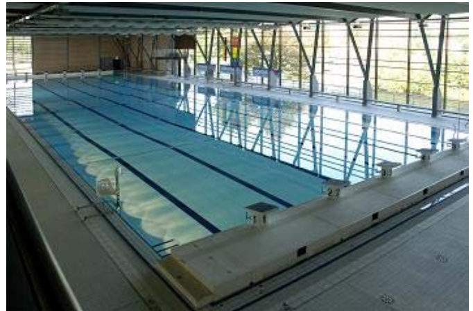
Bild 1: Neue Sportschwimmhalle mit Vario- Schwimmbecken von ca. 50 m x 16,7 m, mit Blick auf die Weiße Elster
