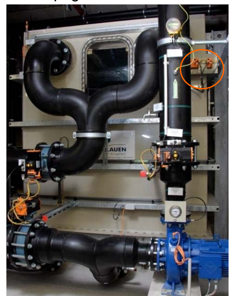
Bild 6: Filter von Firma WTA mit AS-i Modulen AC2516 und AC2507
