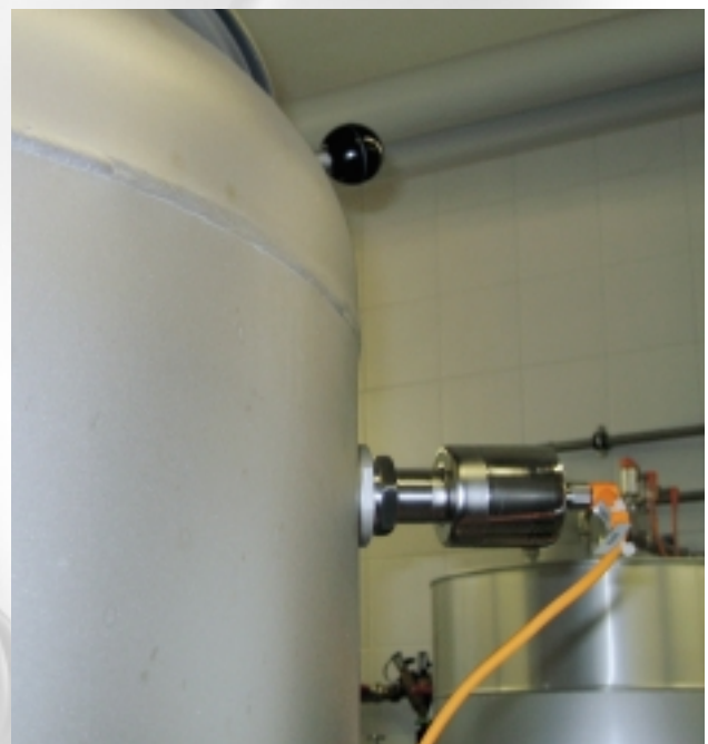
Le transmetteur de température de type TAP dans une application alimentaire, permettant NEP et SEP
