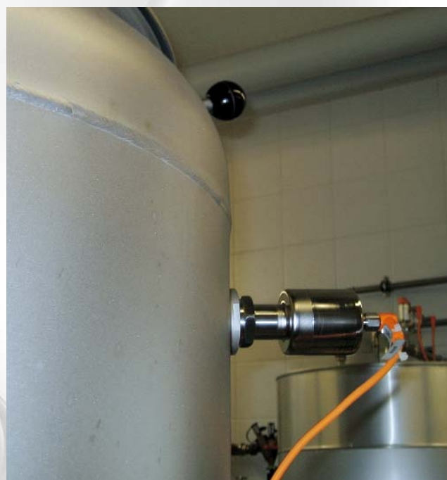
Temperaturtransmitter der Bauform TAP in hygienischer Applikation, CIP- und SIP- fähig
